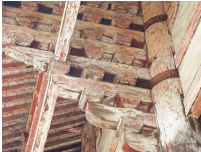
Figura 22: Templo Tōdai-ji en Nara. Detalle del refuerzo estructural en hierro del sistema estructural en madera denominado tokyō . [© Olimpia Niglio, mayo 2013]
