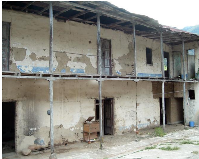
Figura 19: Edificación deteriorada en bahareque en el departamento del Tolima. Casa del escritor Jorge Isaacs, Valle del Combeima. Fuente: Archivo Olimpia Niglio, 2009
