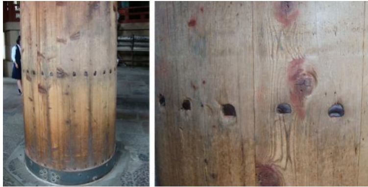
Figura 21: Templo Tōdai-ji en Nara. Detalle del refuerzo estructural del pilar en madera de obtusa (ciprés japonés). [© Olimpia Niglio, mayo 2013]
